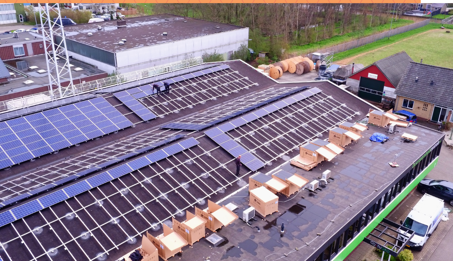
Een van de zonnedaken van de coöperatie Nieuwkoop in aanbouw
